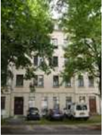
6. MFH Chemnitz Orthstr.
