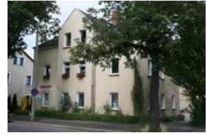
5. MFH Dresden Pirnaer Landstraße
